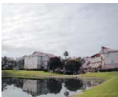
美国佛州别墅区现天坑 房屋坍塌沉降
