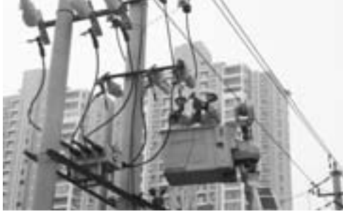
□李飞 报道 ▲济南供电公司员工正在开展带电作业。
