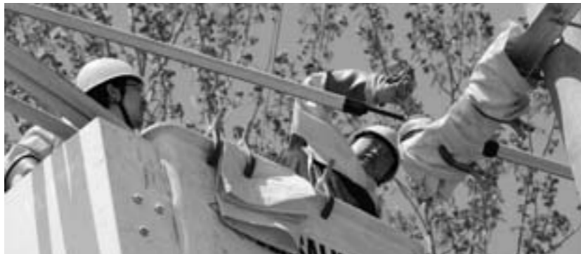
△国网山东莱西市供电公司为保证青岛欣润丰粮油公司如期供电，实施带电立杆作业。保证了李企#1线所带的韩贤锦绣天成有限公司等41家企业和10个村庄的客户和居民正常用电。
