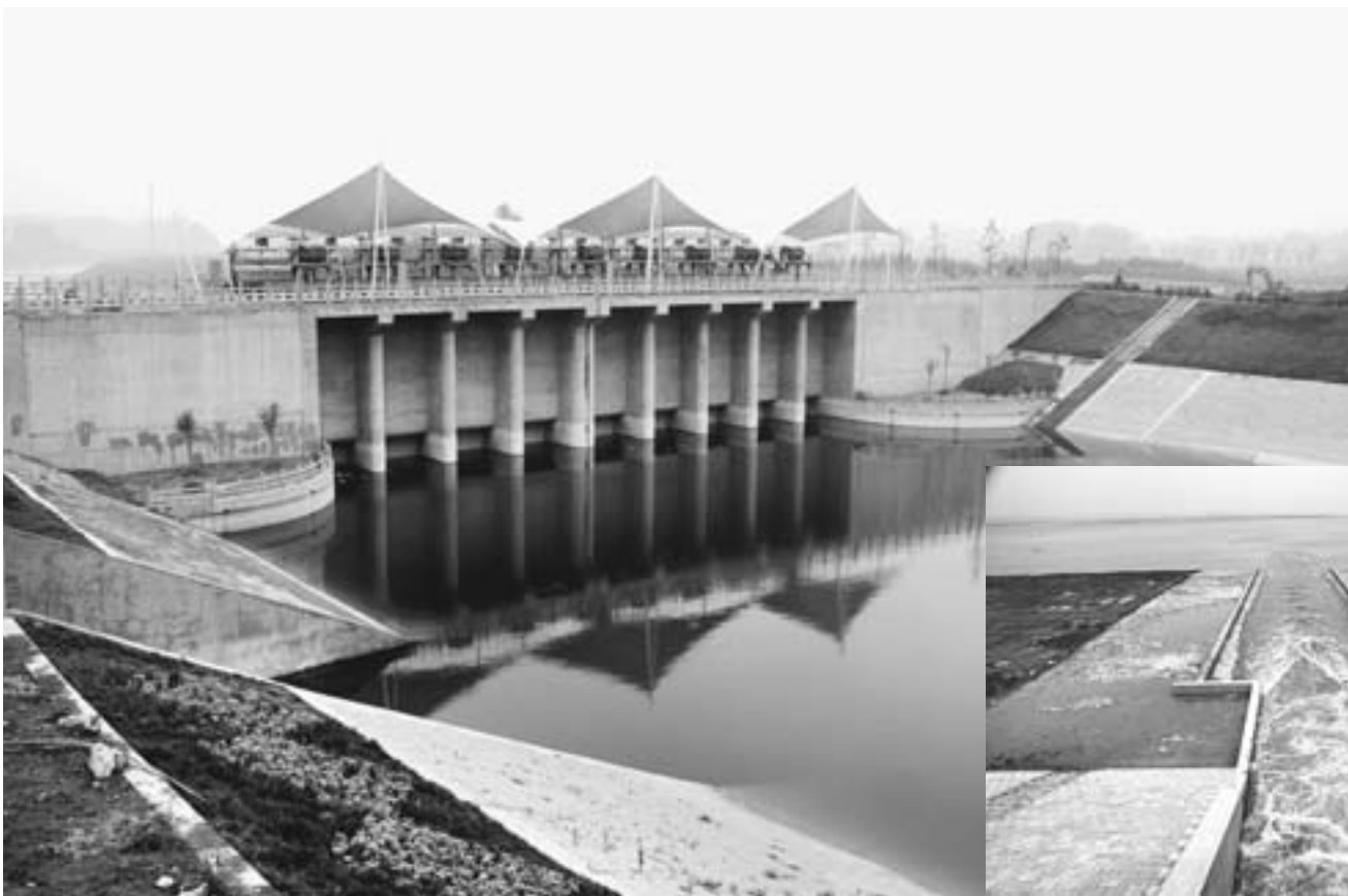
左图：进入山东的第一级泵站台儿庄泵站进水闸。
