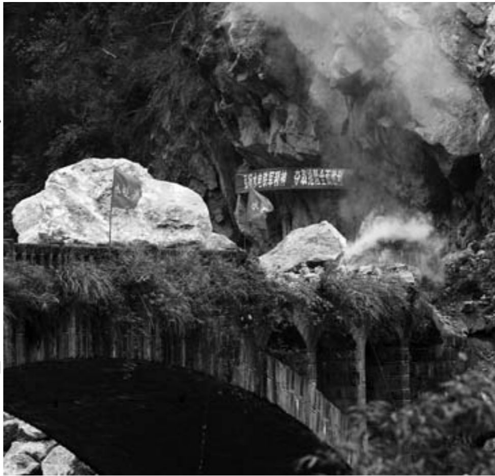
22日上午，武警部队对巨石实施爆破除险。 □记者 李勇 报道
