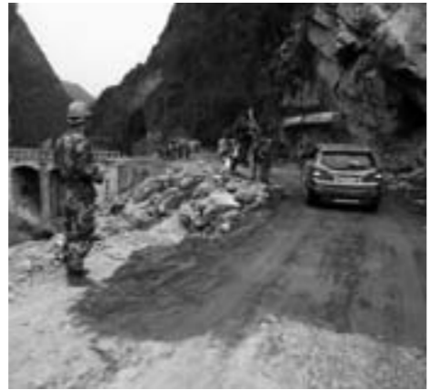
巨石被爆破，道路恢复畅通。
