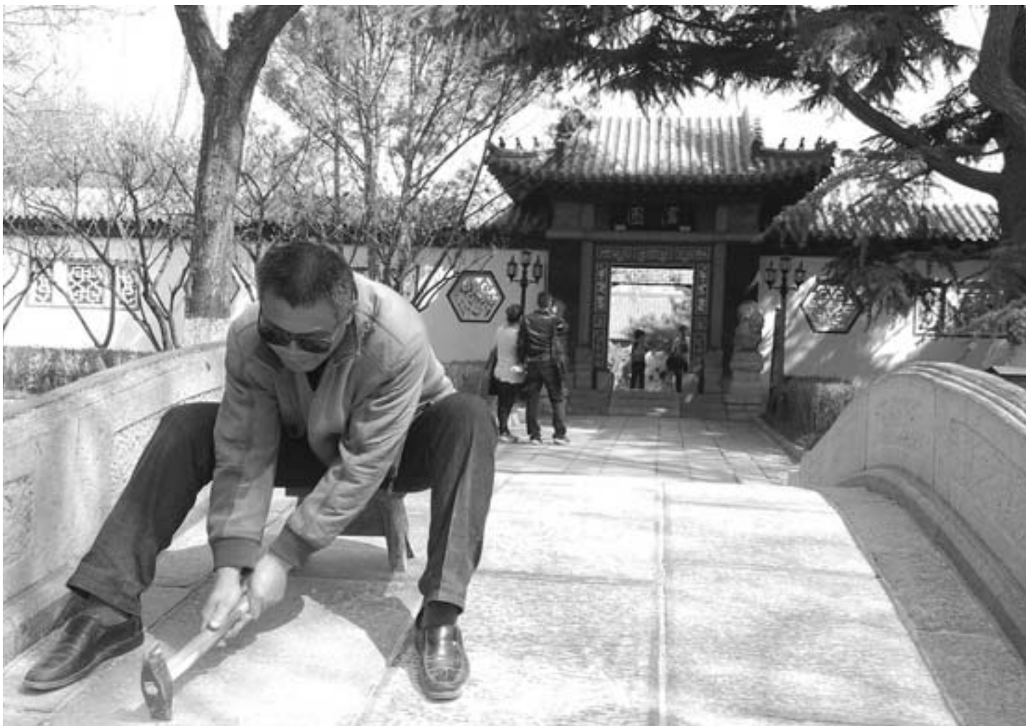
3月27日，一名工作人员在趵突泉公园内一座石桥上做防滑处理。
