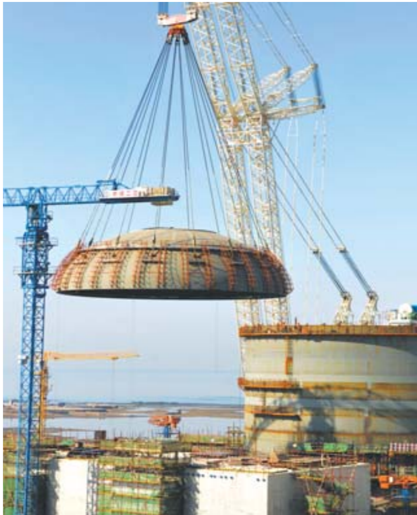
3月29日,吊装中的海阳核电1号机组钢制安全壳顶封头。
