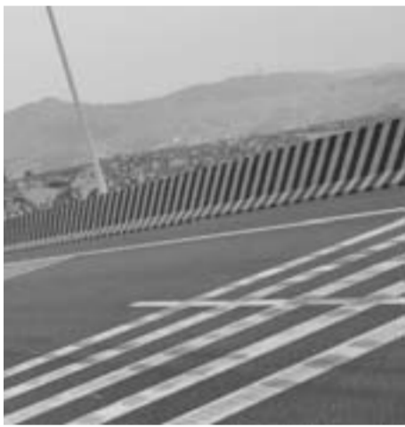
图为将乐隧道道口恶性事故率降至零的防撞墙。
