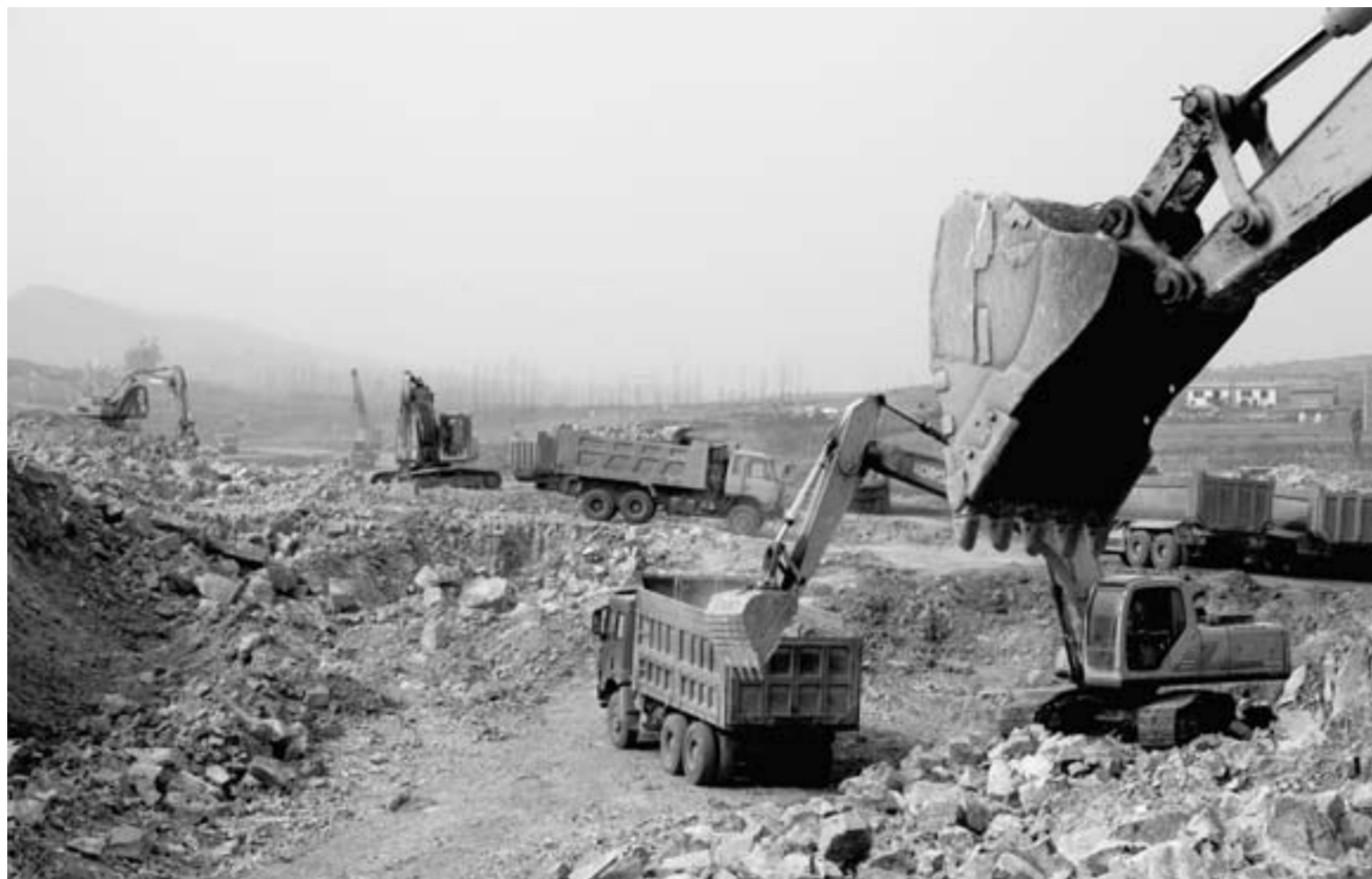
日兰高速公路临沂段高里互通立交工程施工现场。
