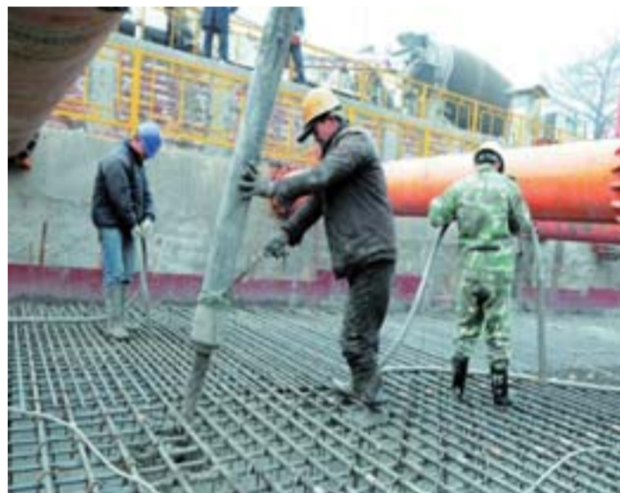
△工人正在进行混凝土浇筑
