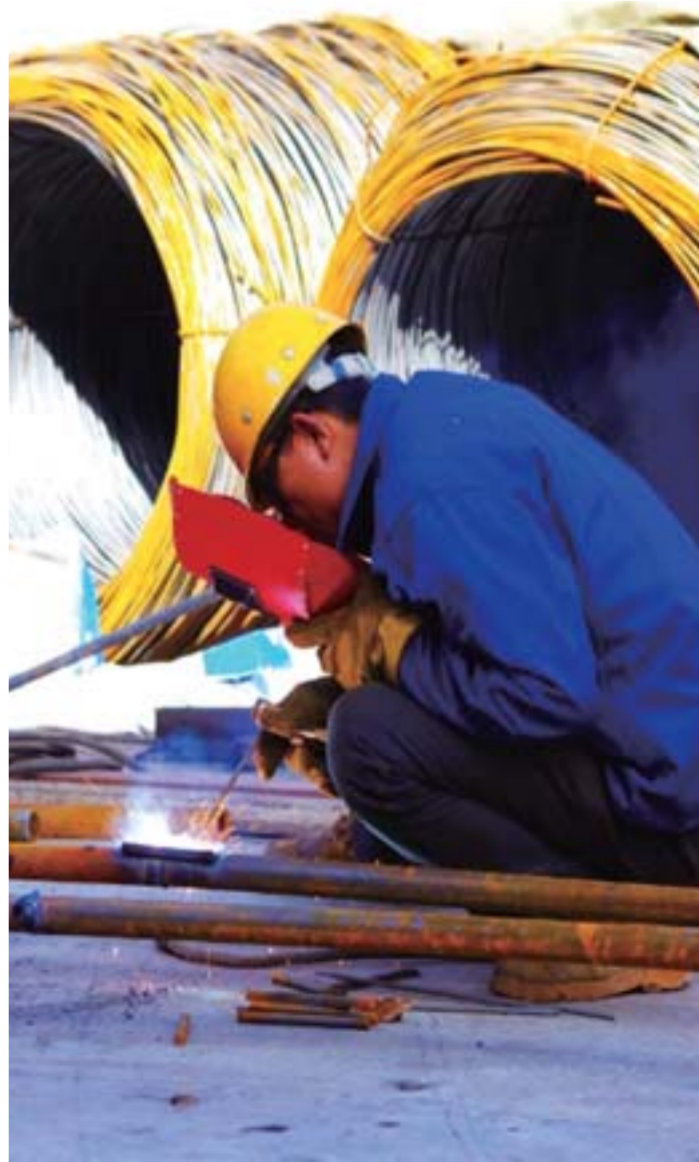
△工人正在进行钢筋焊接
