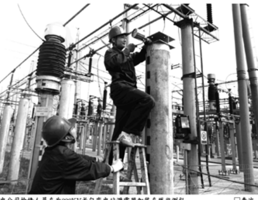
莱芜供电公司检修人员在为220KV长岭变电站避雷器加装在线监测仪。
