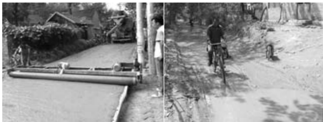
左图为施工中的路面,右图为修建前的路。
