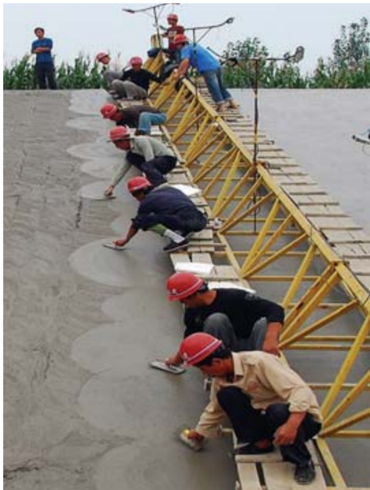
△南四湖至东平湖段工程梁济运河村砌施工
