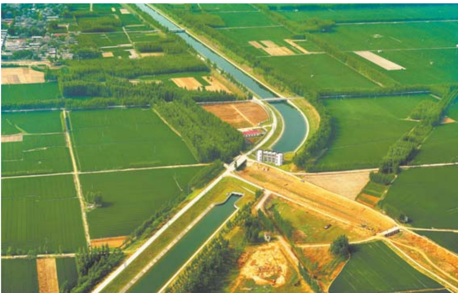
“清水长廊”济平干渠工程
