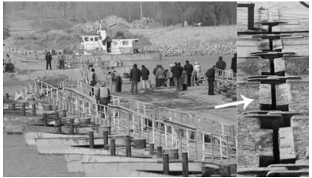
▲左图为浮桥事故现场，右图为承压舟衔接处
