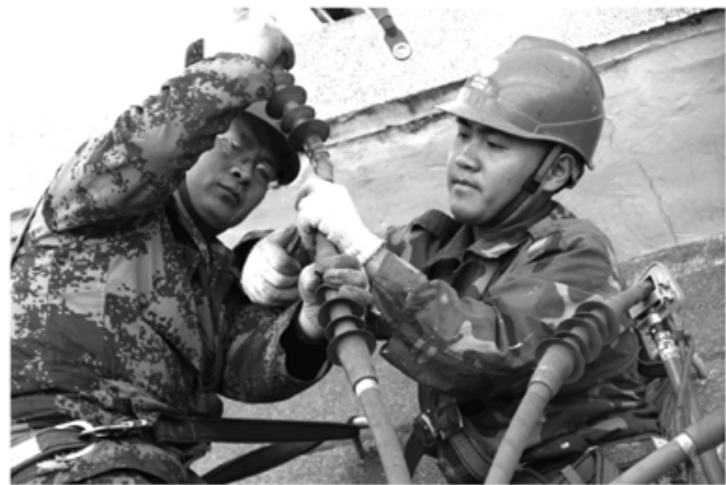
沂水县供电公司电力工人一丝不苟,紧张进行农网施工改造。
