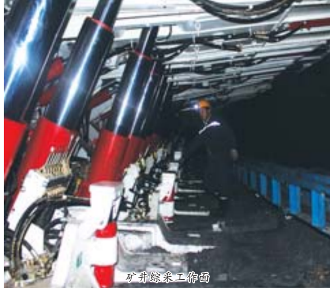
矿井综采工作面
