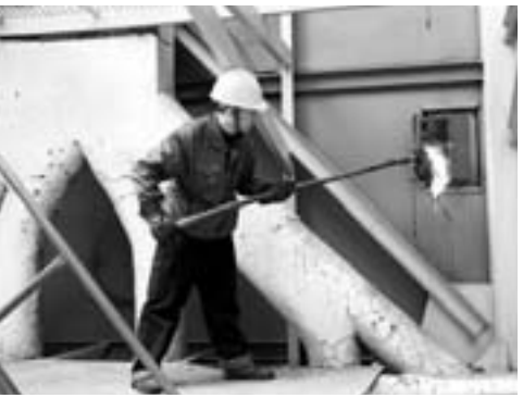
11月11日，东郊热电厂1号锅炉前，工作人员点火启动锅炉。
