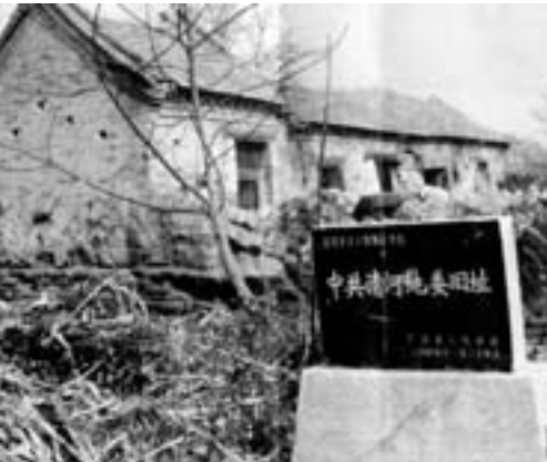
中共清河地委(后为渤海区)旧址
