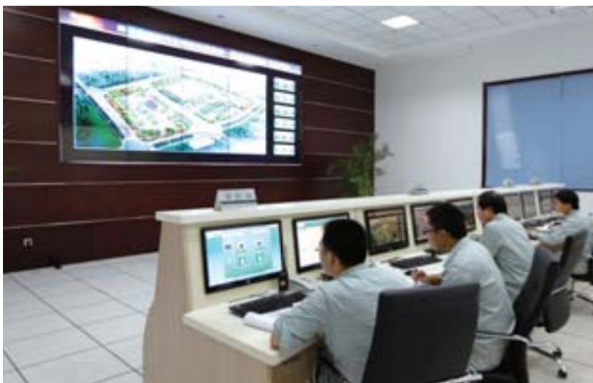
▲薛家岛充换电站监控室
