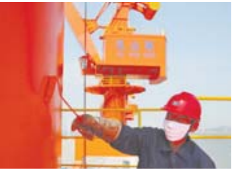
□彭辉 刘国贤 报道 6月14日,一位工人在乳山市乳山口新港的起重机上喷漆。2009年5月开工的乳山新港一期工程,总投资2.05亿元,位于国家二类开放港乳山口港东岸。今年6月初,4台新式起重机“安家”已建成的两个两万吨级散杂货泊位码头,标志着新港码头主体建设工程完工。目前正在进行仓库等配套设施建设,预计9月底一期工程将全部完工,投入使用后将作为山东半岛蓝色经济区建设中青岛、烟台、威海三大港口海上货运配套和周转的中枢,年吞吐量可达180万吨。
