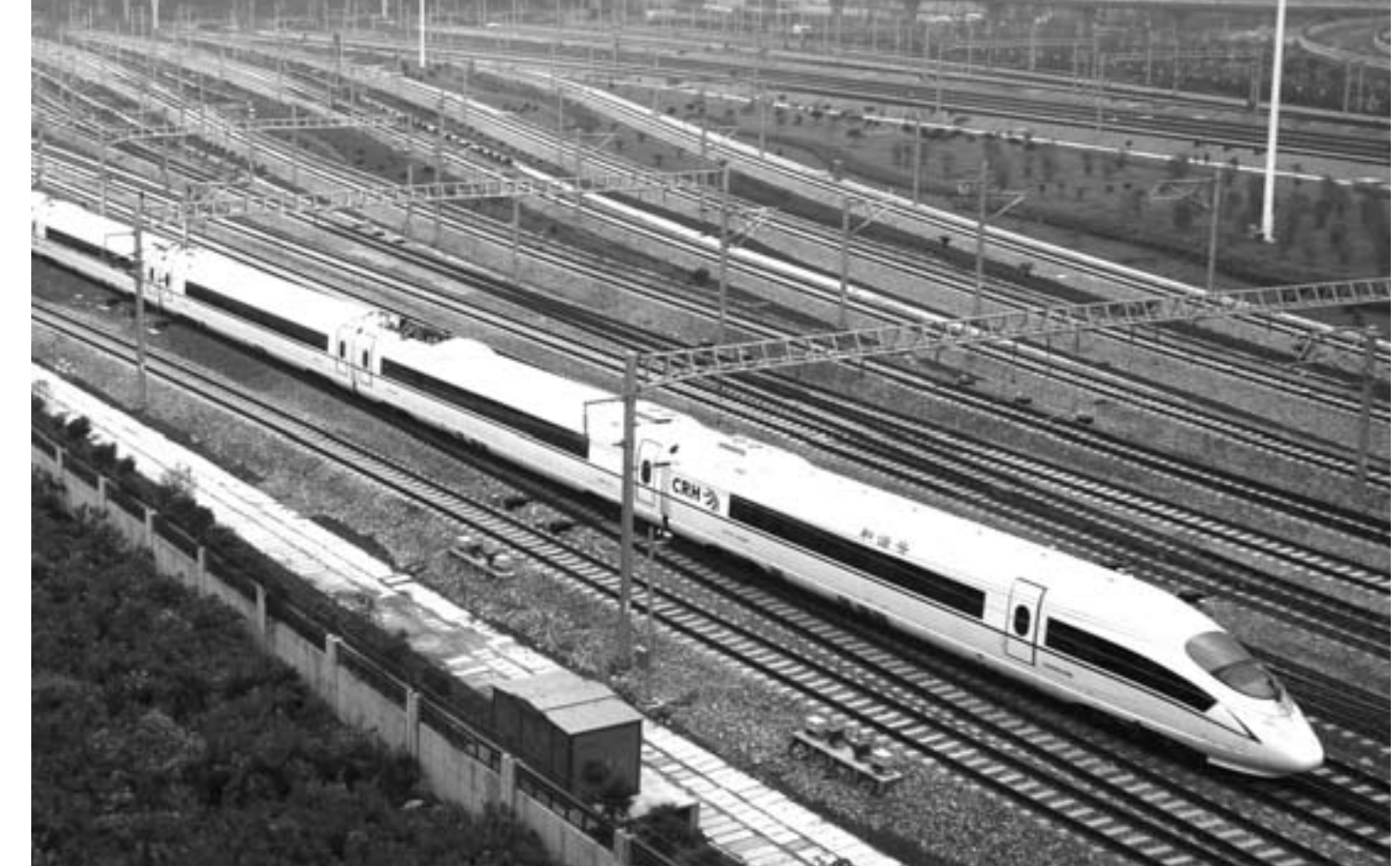
6月12日，一辆试运行的京沪高铁CRH380B动车驶离上海虹桥站。
