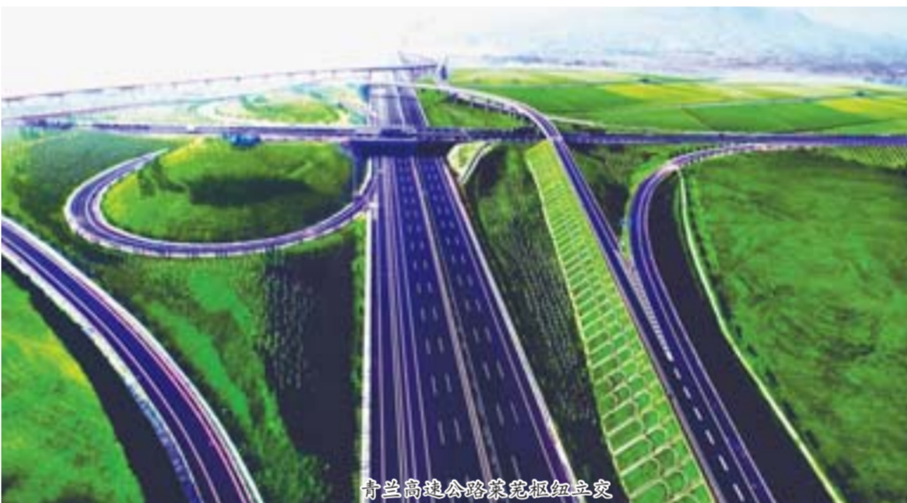
青兰高速公路示范样板路
