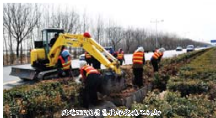
国道206线昌邑段绿化施工现场
