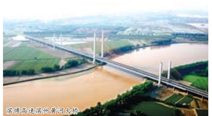
滨博高速滨州黄河大桥
