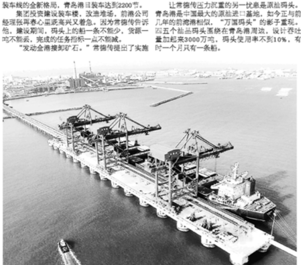
蔚为壮观的青岛港20万吨级矿石码头。
