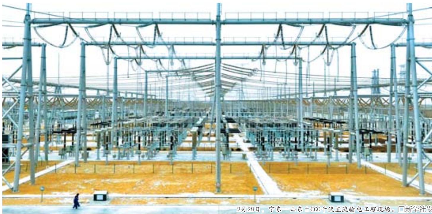
2月28日,宁东—山东±660千伏直流输电工程现场。□新华社发
