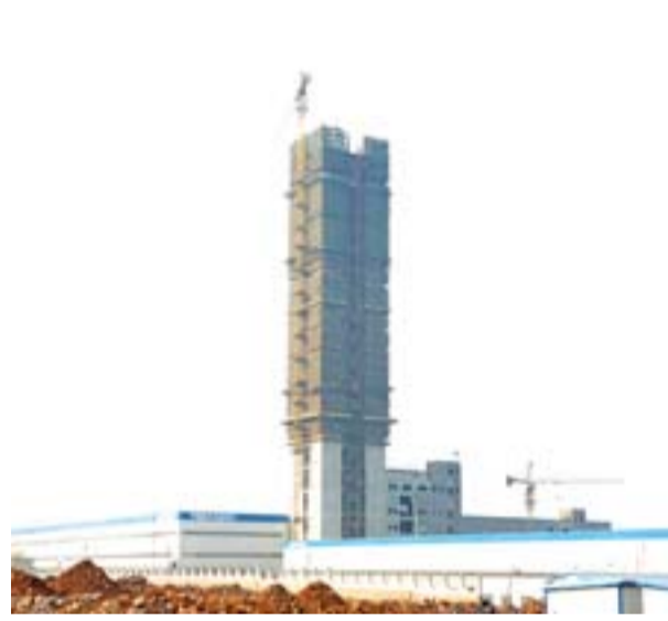
特变电工华东输变电科技产业园
