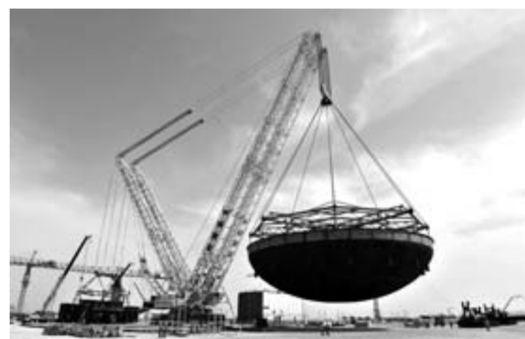
海阳核电站核岛设备吊装
